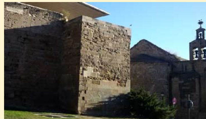
Mur aplomat. Restes de la muralla medieval de Sant Martí de Lleida
