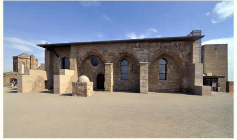
Nordfassade des alten Gerichtssaals
