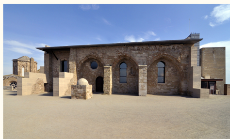
Façana nord de l'antiga sala de Corts
