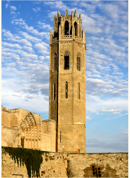
Glockenturm und Tor der Apostel
