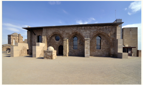
Noordelijke façade van de vroegere hofzaal
