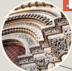
Archivolts detail. Main Gate
