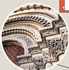
Detalle arquivoltas. Portal Mayor
