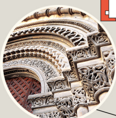
Detalle arquivoltas. Portal Mayor
