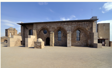
Fachada norte de la antigua Sala de Cortes
