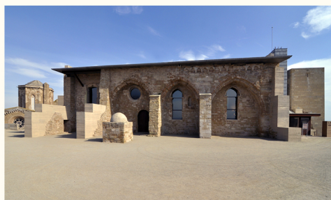
Fachada norte da antiga sala de Cortes
