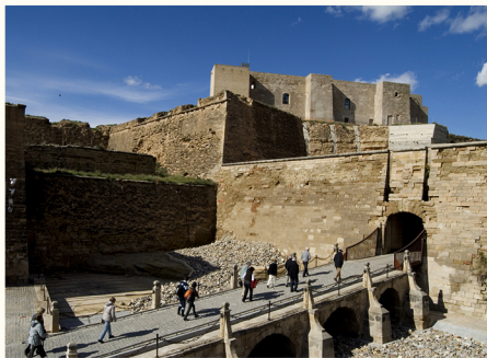
Castelo do Rei - La Suda desde a ponte levadiça
