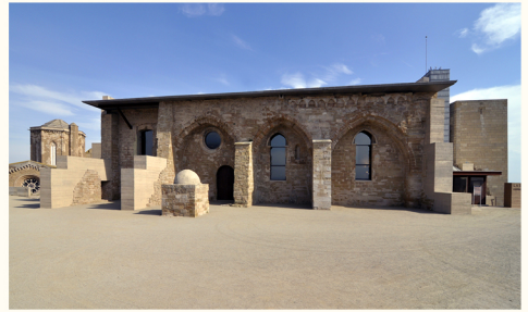
Façade nord de l'ancienne salle des Corts
